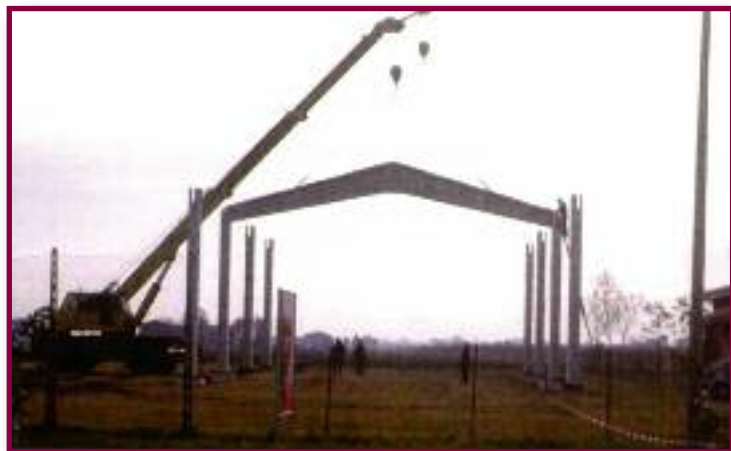
1986: la Chiesa di Crocetta in costruzione
